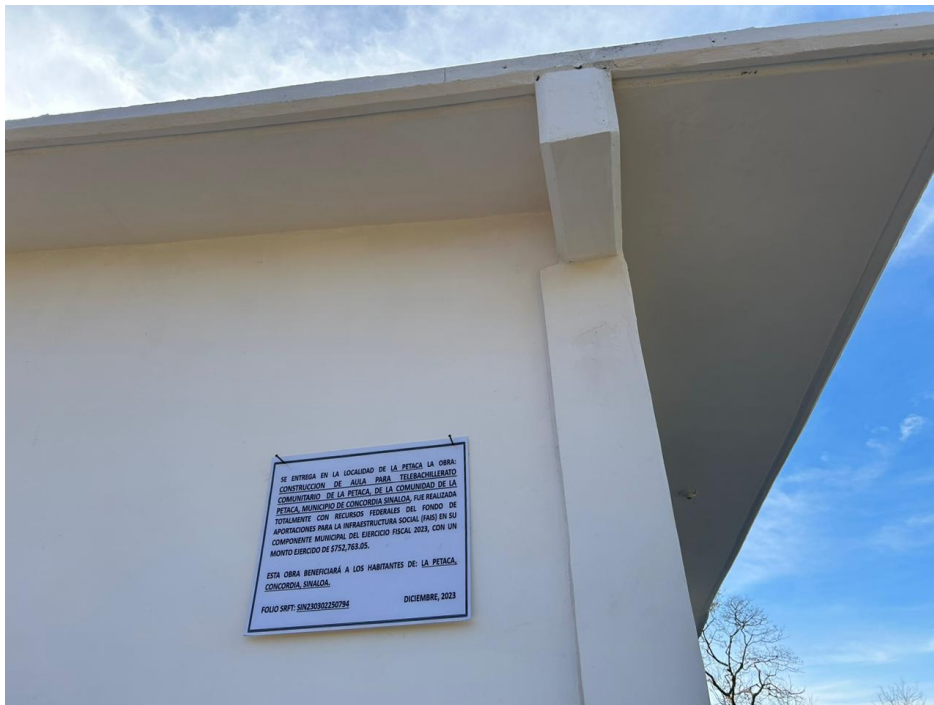
Construcción De Aula Para Telebachillerato Comunitario La Petaca, De La Comunidad De La Petaca, Municipio De Concordia, Sinaloa.
